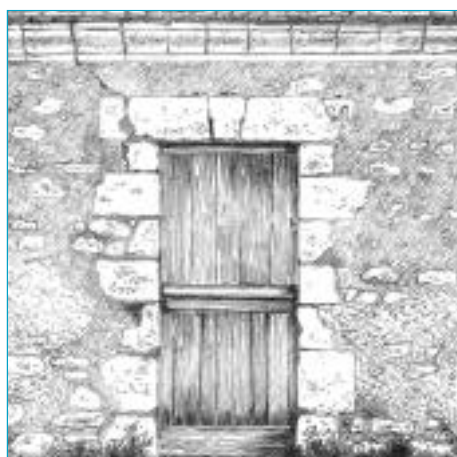
Détail de porte de ferme
